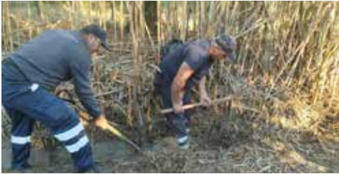
Limpeza de valetas
