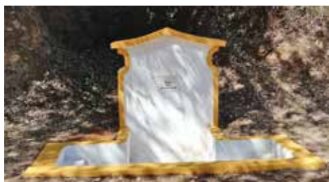
Fonte Ferrada em Santo António – Limpeza e pintura
