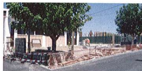
Obras no logradouro da Junta de Freguesia
